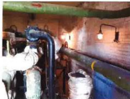
Boilerinė 1H1p (u.n. 8198-8005-6010), sklypo fragmentas
