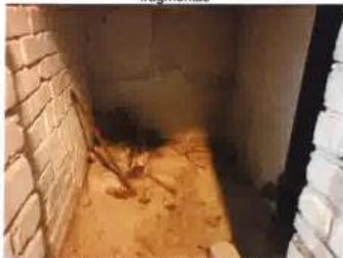
Boilerinė 1H1p (u.n. 8198-8005-6010), sklypo fragmentas
