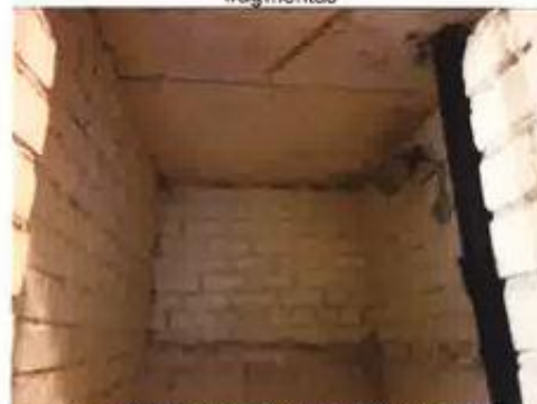
Boilerinė 1H1p (u.n. 8198-8005-6010), sklypo fragmentas
