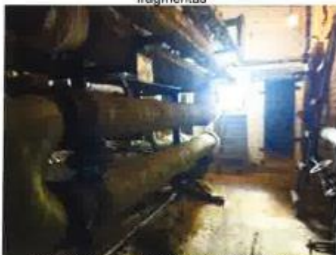
Boilerinė 1H1p (u.n. 8198-8005-6010), sklypo fragmentas
