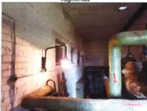
Boilerinė 1H1p (u.n. 8198-8005-6010), sklypo fragmentas
