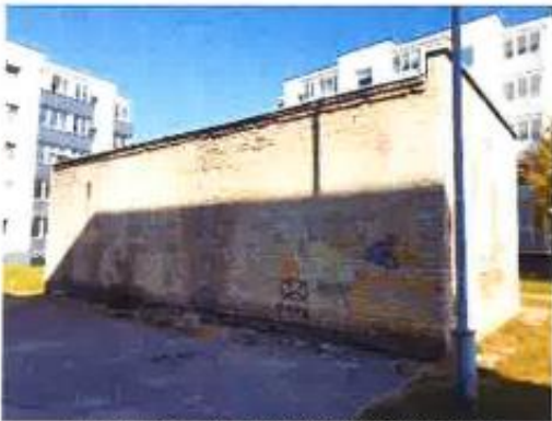
Boilerinė 1H1p (u.n. 8198-8005-6010), sklypo fragmentas
