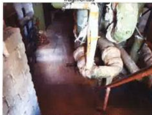
Boilerinė 1H1p (u.n. 8198-8005-6010), sklypo fragmentas
