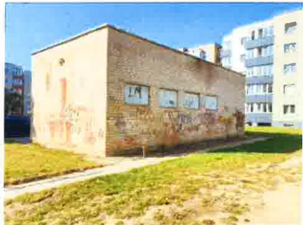
Boilerinė 1H1p (u.n. 8198-8005-6010), sklypo fragmentas
