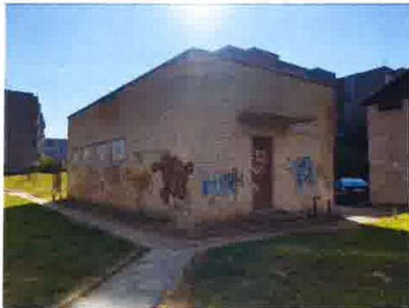
Boilerinė 1H1p (u.n. 8198-8005-6010), sklypo fragmentas
