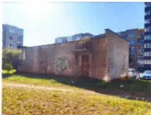
Boilerinė 1H1p (u.n. 8199-0007-3011), sklypo fragmentas
