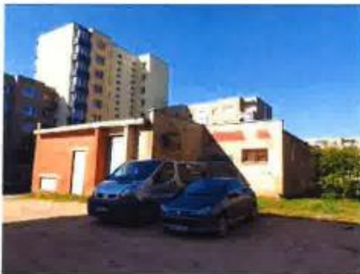
Boilerinė 1H1p (u.n. 8199-0007-3011), sklypo fragmentas
