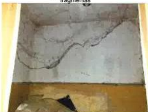
Boilerinės 1H1p (u.n. 8199-0007-3011) vidaus fragmentas
