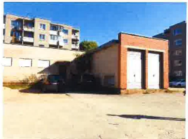
Boilerinė 1H1p (u.n. 8199-0007-3011), sklypo fragmentas
