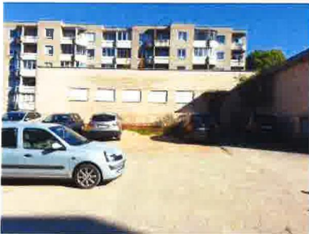
Boilerinė 1H1p (u.n. 8199-0007-3011), sklypo fragmentas
