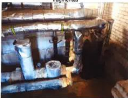
Boilerinės 1H1p (u.n. 8199-0007-3011) vidaus fragmentas
