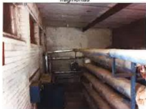
Boilerinės 1H1p (u.n. 8199-0007-3011) vidaus fragmentas
